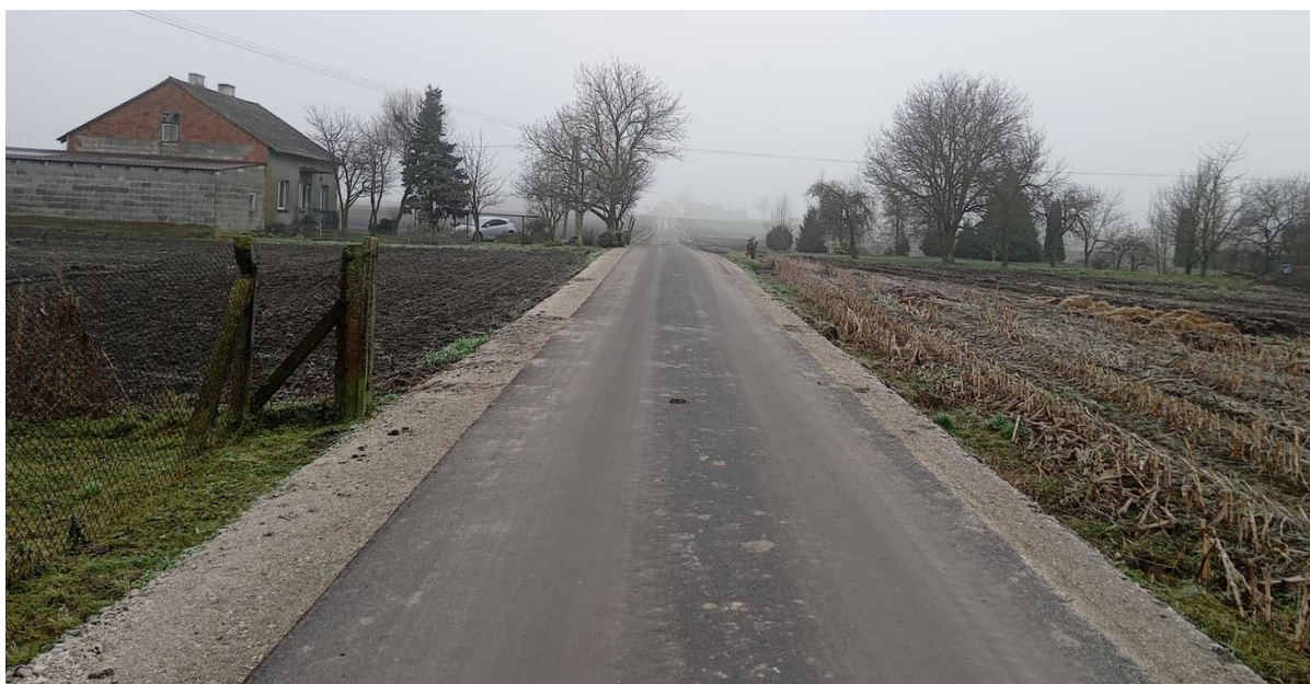
Źródło: Urząd Gminy w Aleksandrowie Kujawskim „Budowa chodnika na ul. Okrężnej w miejscowości Odolion”
